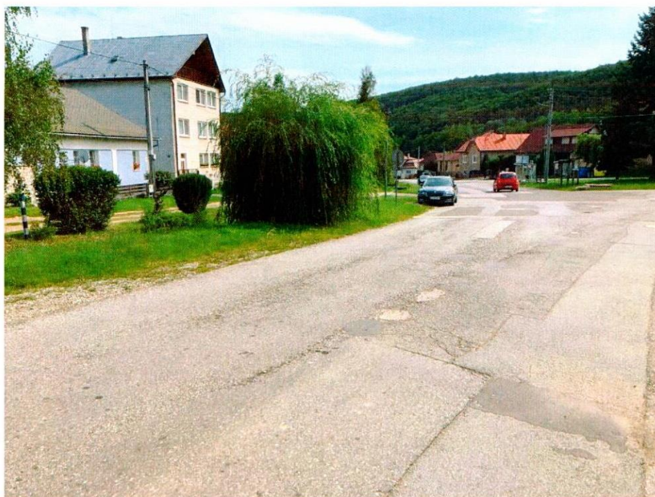
Obrázok č.6 – pohľad na štruktúru existujúcich porúch
