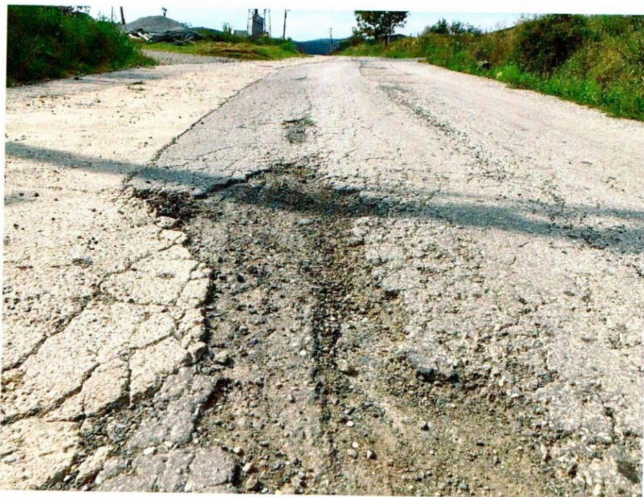
Obrázok č.3 – detail na výtłk
